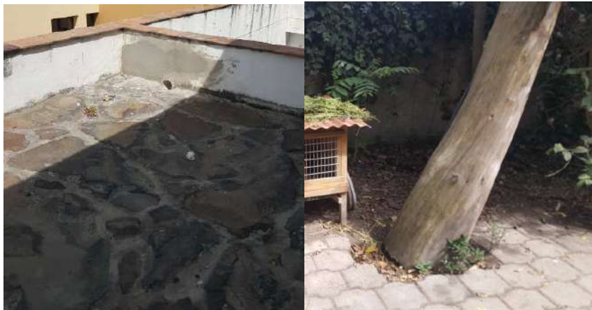
Figura 72. Pisos exterior de la vivienda
