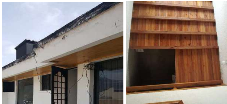
Figura 62. Cubierta y Cielo raso de madera
