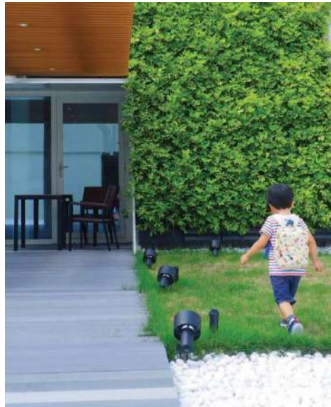
Figura 37. Reflectores dirigibles en el ingreso del Centro
