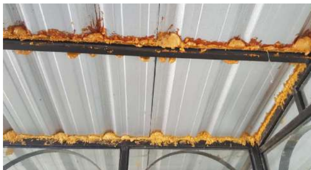
Figura 63. Cubierta metálica en la terraza
