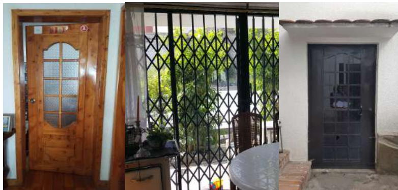
Figura 61. Puertas y Ventaneria de la vivienda
