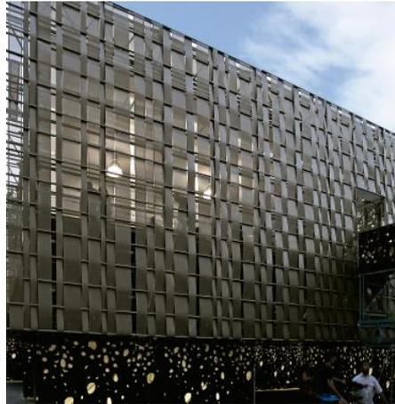
*Figura 30.* Fachada ventilada Stripwave
