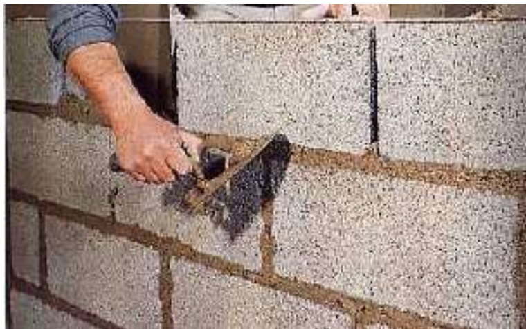
Figura 33 Colocación de mezcla
