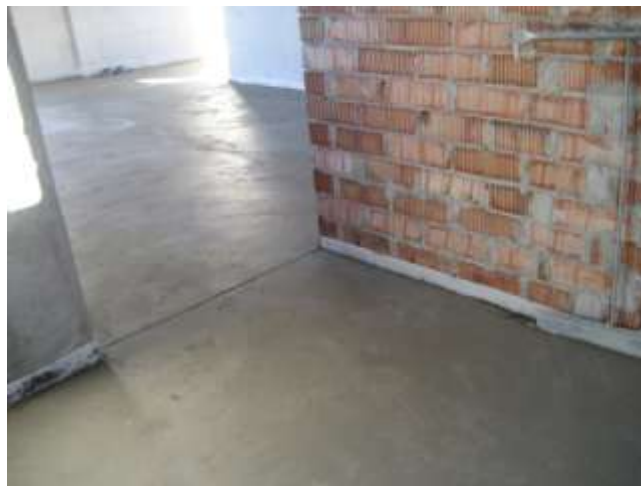
Figura 11 Mortero para Pavimentos
