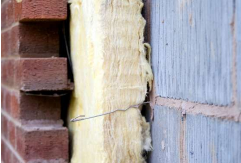
Figura 7 Aislamiento con lana de roca
