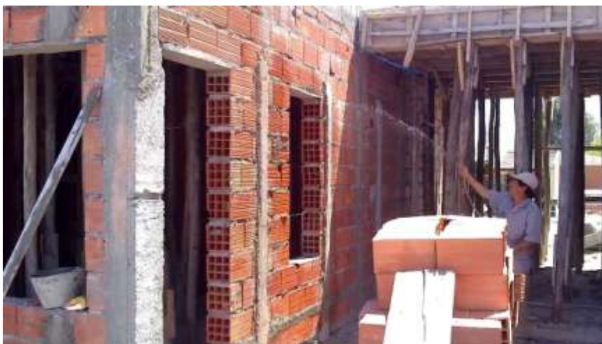
Figura 31 Proceso de colocación del mortero
