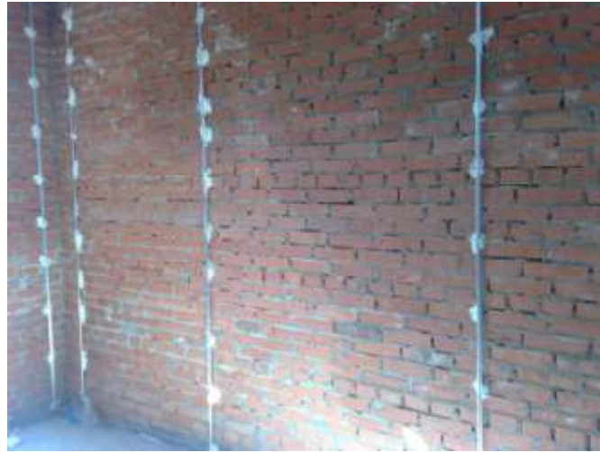
Figura 32 Colocación de maestras
