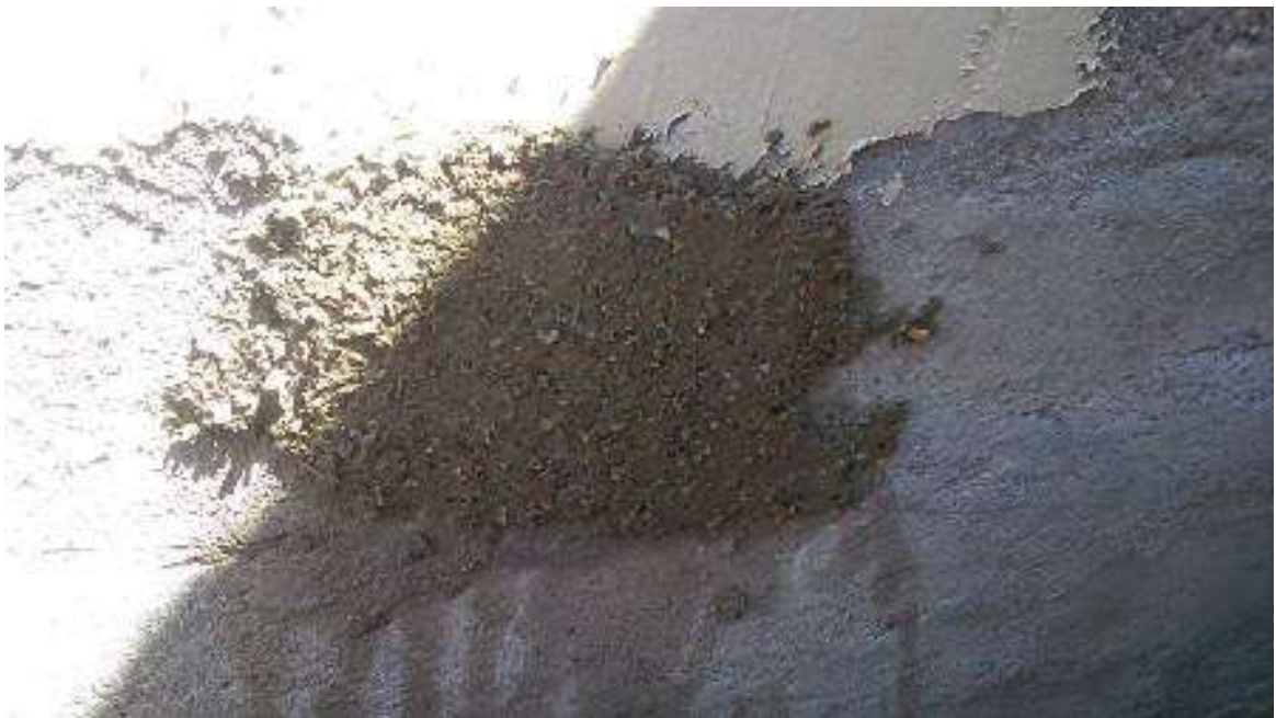
Figura 51 Mortero colocado en la pared
