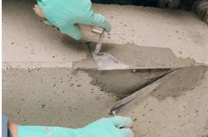
Figura 13 Mortero de Reparación
