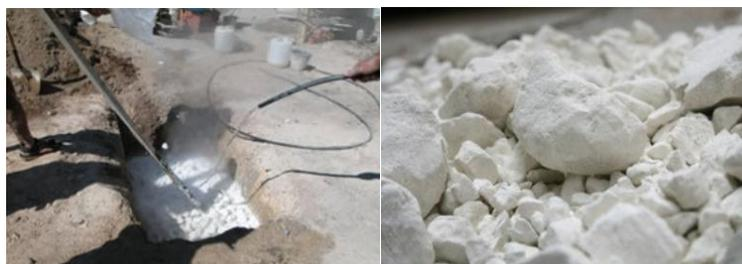
Figura 31. Apagado de cal y Cal viva.
