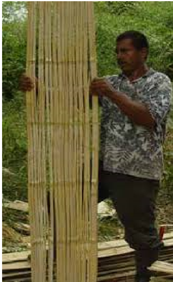
Figura 61. Colocación de esterilla de guadua.
