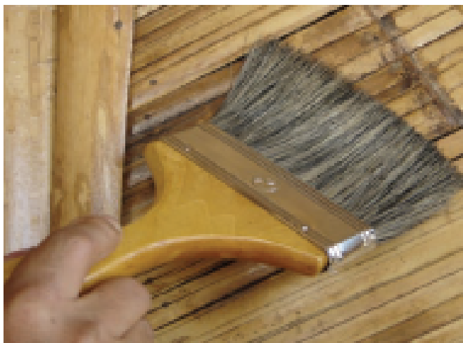
Figura 68. Protección de esterillas de guadua
