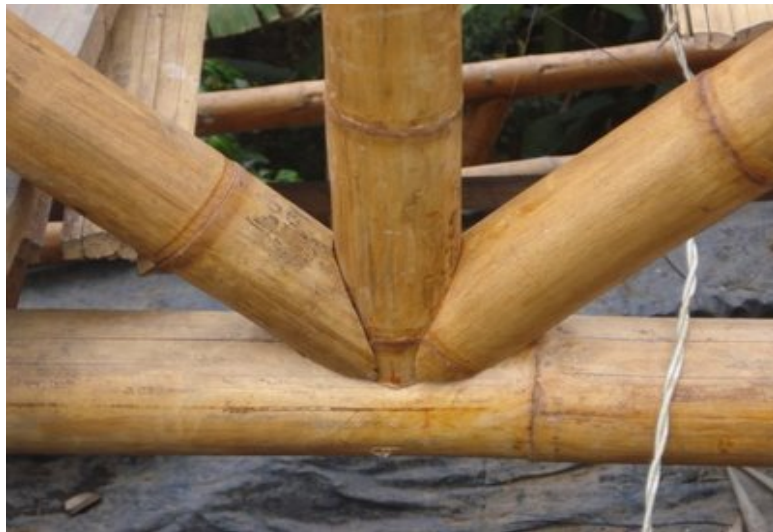
Figura 50. Corte Pico de Flauta Tomado de: (Guaduabambucolombia, 2015)
