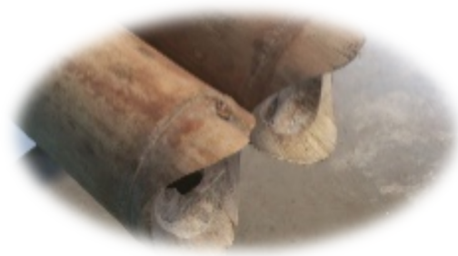
Figura 39. Corte en boca de pescado
