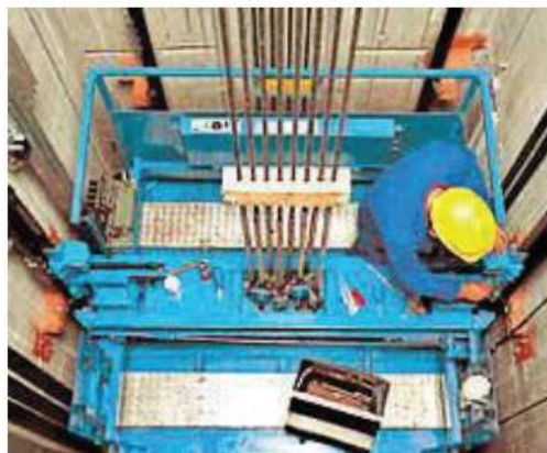
Figura 16 Cables de suspensión Tomado de: Cunuhay & Pazmiño, (2015)
