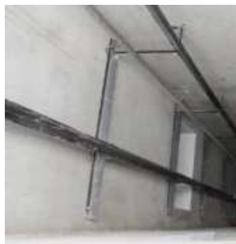
Figura 10 Guía de cabina Tomado de: Ascensores y más, (2016)
