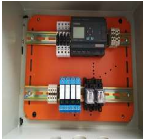
Figura 45 Colocación de riel y componentes
