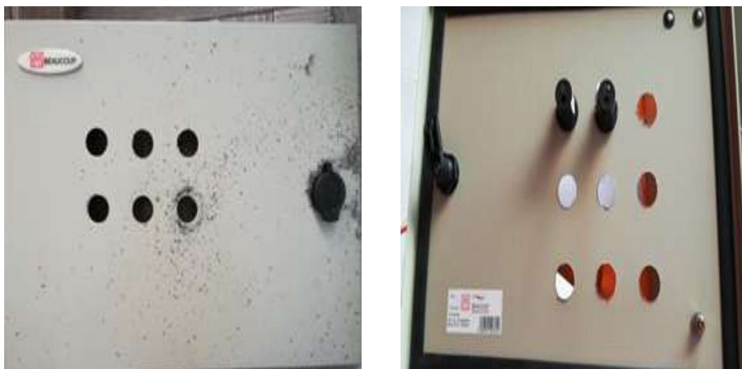
Figura 44 Perforación del tablero y colocación de luces
