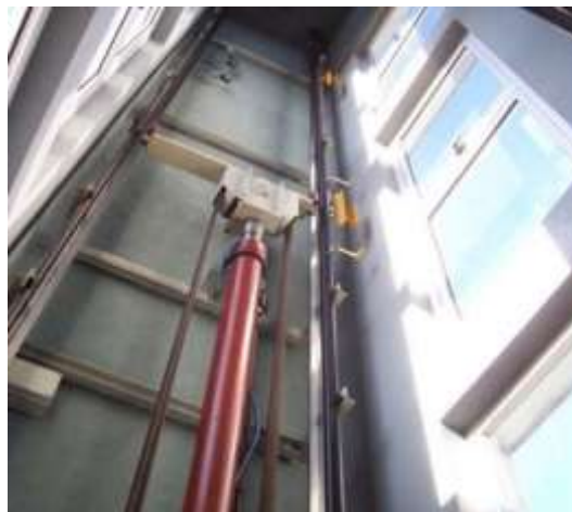
Figura 6 Ascensor hidráulico Tipo pistón lateral Tomado de: ELEVAL, (2016)
