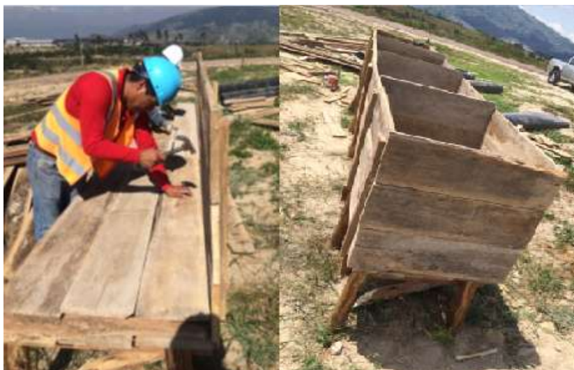
Figura 5. Construcción de los lechos de compostaje.
