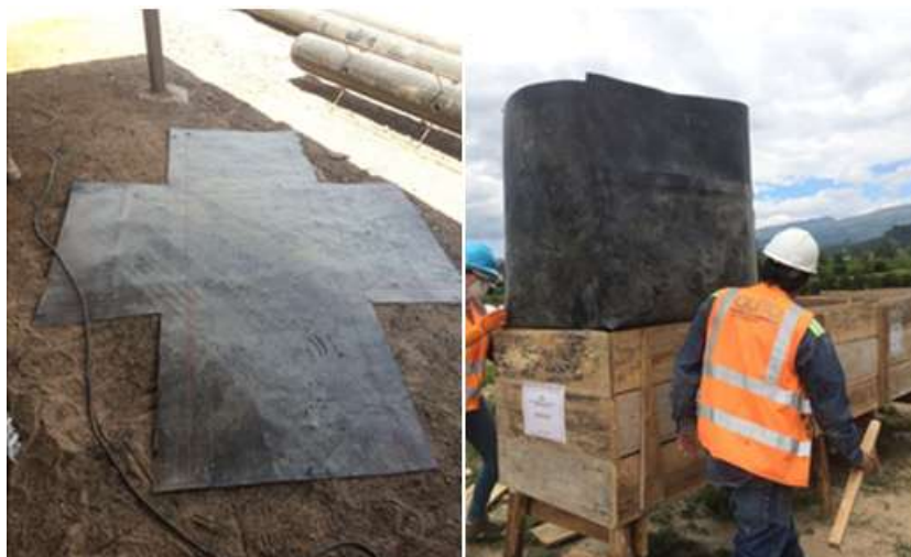
Figura 7. Impermeabilización de los lechos de compostaje con geomembrana.
