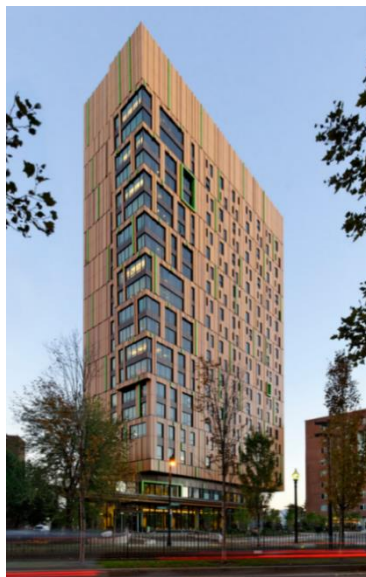
Figura 35, Edificio residencia estudiantil de artes.
