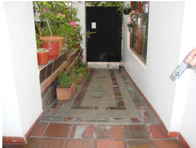
Figura 78. Rampa de acceso.
