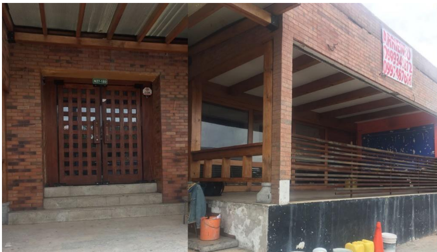
Figura 50. Local antes de la adecuación
