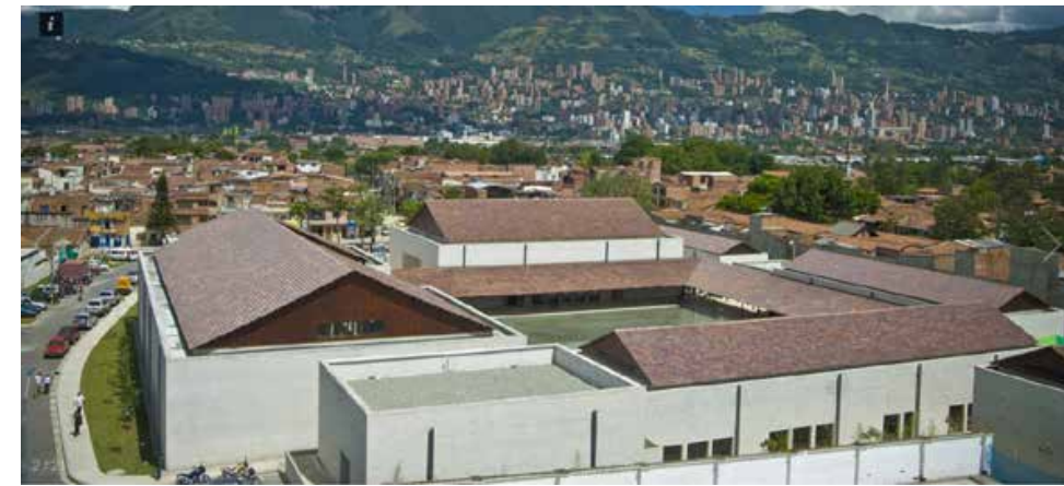
Figura 96. Biblioteca Belén Tomado por Plataforma de Arquitectura
