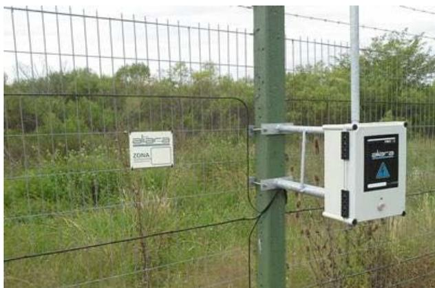
*Figura 54.* Cable sensor microfónica de seguridad.
