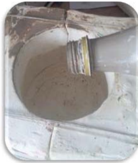
Figura 379. Colocacion de barbotina
