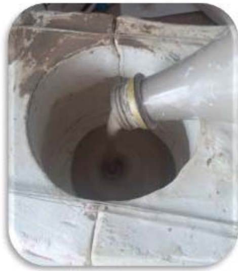
Figura 380. Colocacion de barbotina
