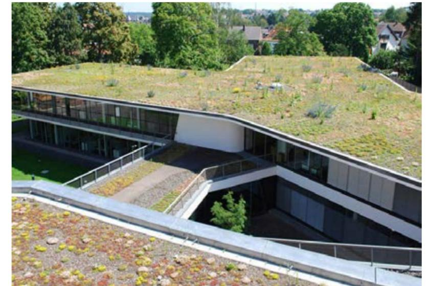
Figura 40. Cubierta extensiva Tomado de (Archiexpo,s.f.)
