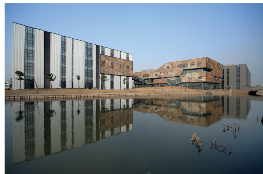
Figura 56: Pequeño Centro de Exhibiciones Tomado de (Biblioteca de Arquitectura, 2011).
