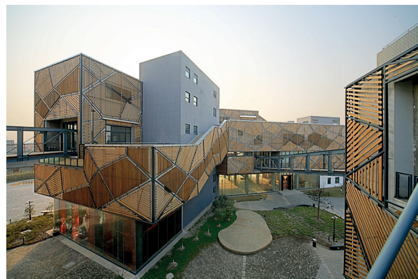
Figura 55: Pequeño Centro de Exhibiciones Tomado de (Biblioteca de Arquitectura, 2011).
