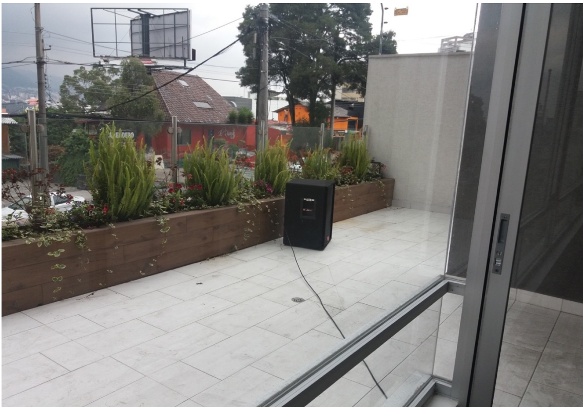
20. Medición a ruido de fachada
