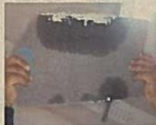
Anexo2. Humedad en la Teja 3 Parcialmente Húmeda
