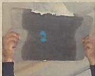
Anexo1. Humedad en la Teja 2 Húmeda
