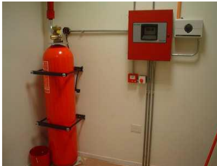
Figura 17. Sistema de detección y extinción de incendios
