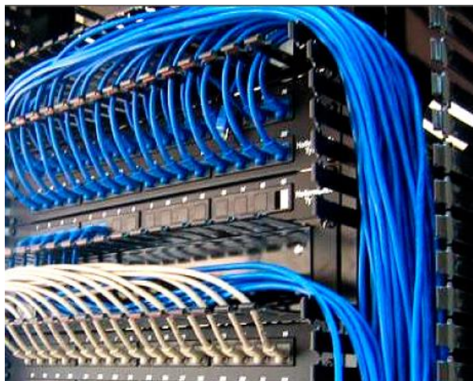
Figura 14. Patch Panel de cableado horizontal
