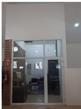
Figura 19. Acceso Data Center Rosaprima R1
