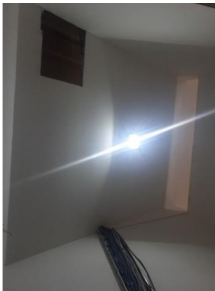
Figura 20. Densidad de Iluminación
