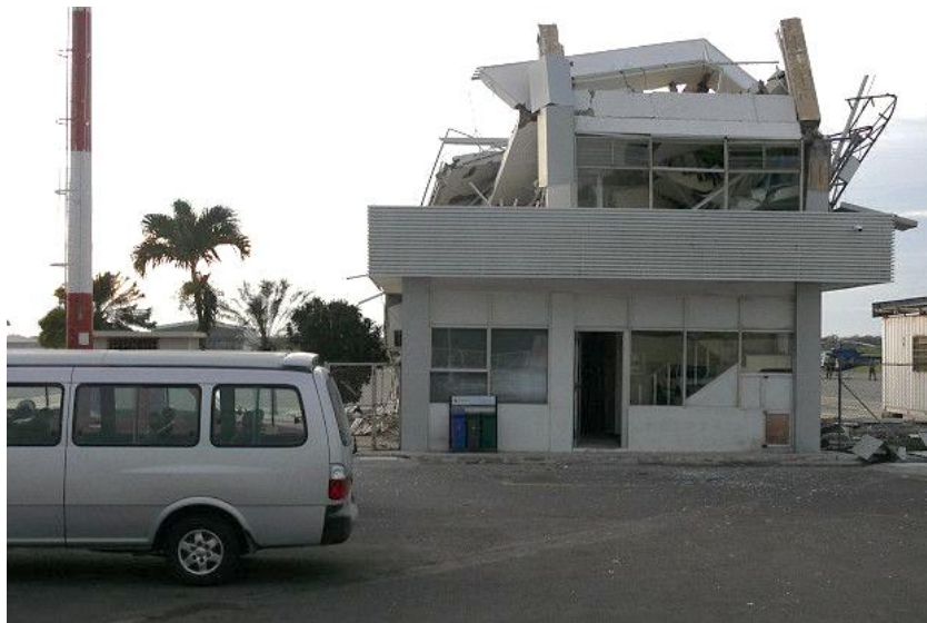
Figura 15: Torre de control tras terremoto Tomado de (Menéndez Wendy, 2016)
