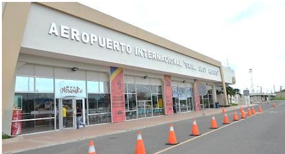
Figura 13: Terminal Manta Tomado de (El UNIVERSO & Ríos, 2005)
