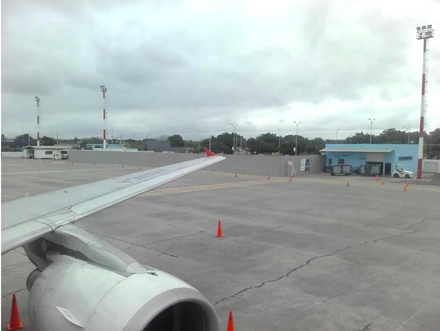
Figura 3: Terminal aérea actualmente derrocada.
