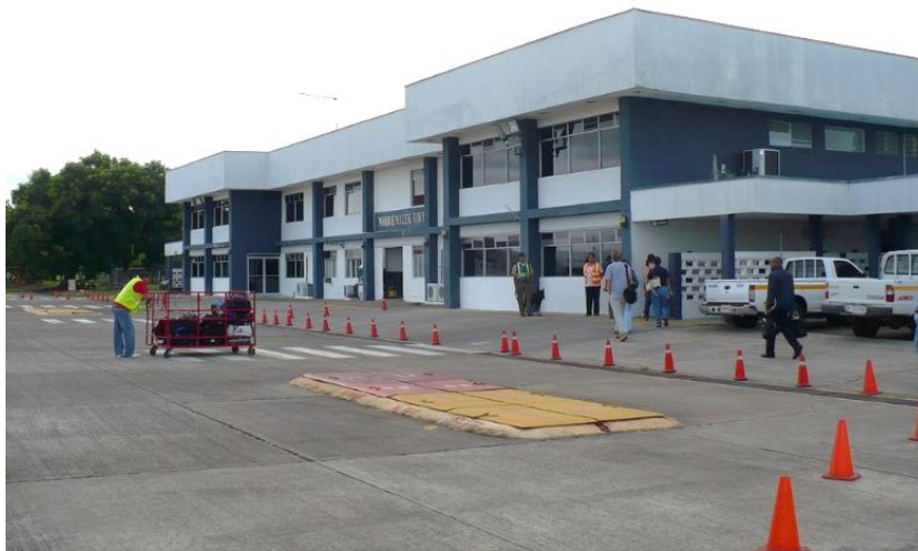
Figura 38: Exterior terminal aérea
