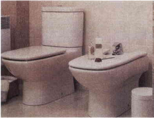
10. sanitarios "Roca" de porcelana blanca pergamon.
