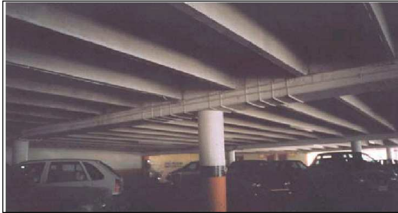
Figura 4.2: Detalle de columnas y vigas
