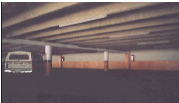
Figura 4.1: Detalle de columnas y vigas
