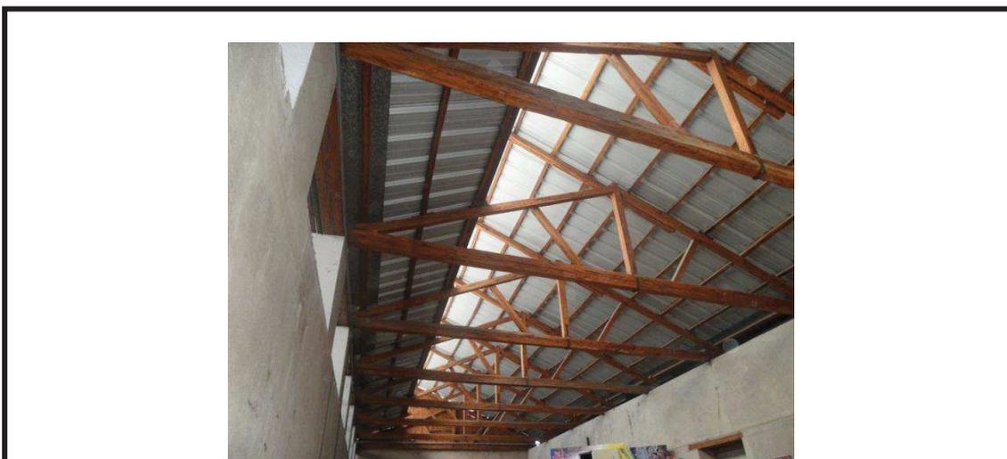
Figura 62. Fotografía de la cubierta cerchada de madera de la bodega No.2 del Área Tulipe del MIC.
