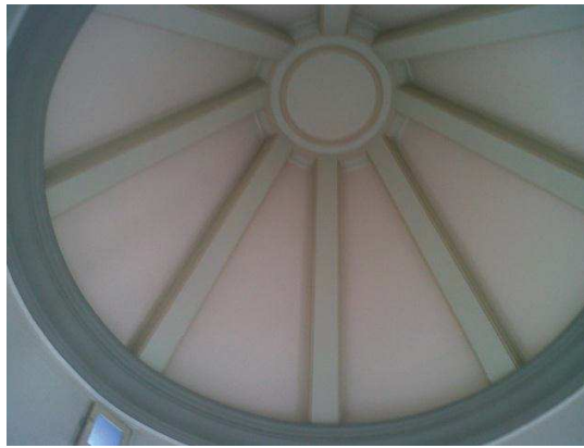
Figura 60. Cielo raso torre circular. Castillo Larrea.
