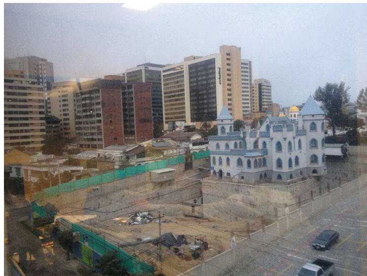
Figura 3. Fotografía de la obra actual.
