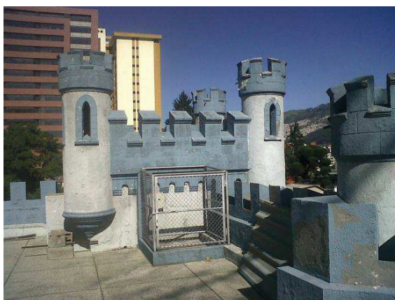
Figura 58. Vista terraza. Castillo Larrea.
