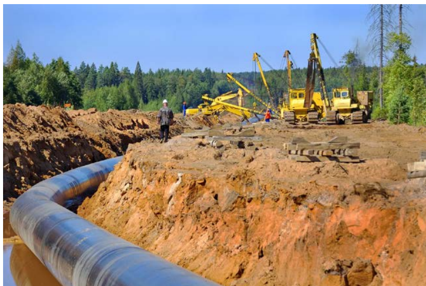
Construcción de una Línea de Producción
