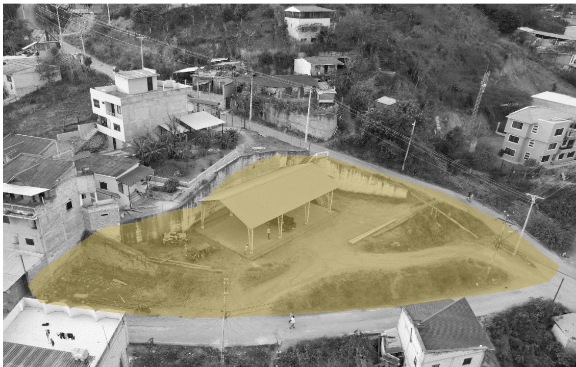
FIGURA 89: Imagen área de parque “El Calvario” estado actual, (Galindo, 2023)
