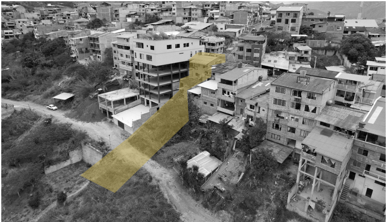
FIGURA 75: Barranco de la avenida Rafael Galarza a ser intervenido. (Galindo, 2023)
