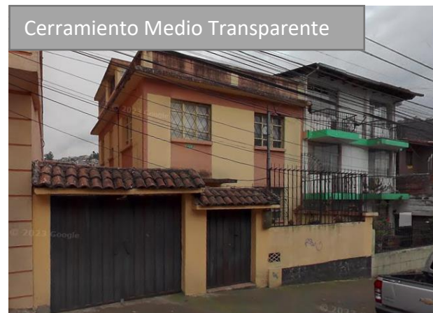
Imagen 29 "Cerramiento Casas" Fuente: Google Maps
