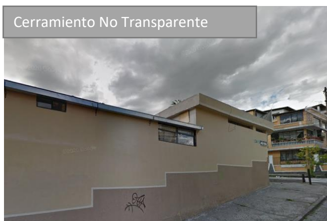
Imagen 28 "Cerramiento Casas" Fuente: Google Maps
