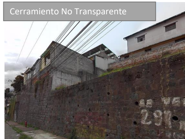
Imagen 27 "Cerramiento Casas" Fuente: Google Maps
