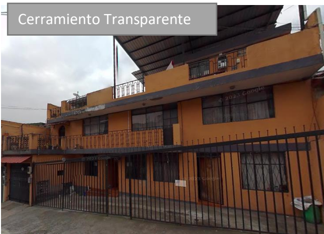
Imagen 26 "Cerramiento Casas" Fuente: Google Maps
