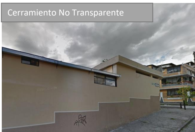
Imagen 28 "Cerramiento Casas" Fuente: Google Maps
