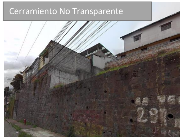
Imagen 27 "Cerramiento Casas" Fuente: Google Maps
