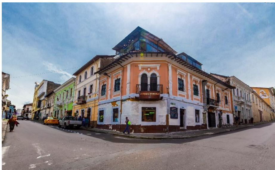
Fotografía 12: Esquina de los cuatro radios, La Tola Elaborado por: John Atencia y Sebastián Yáñez Fuente: Andrés Camacho, 2023
