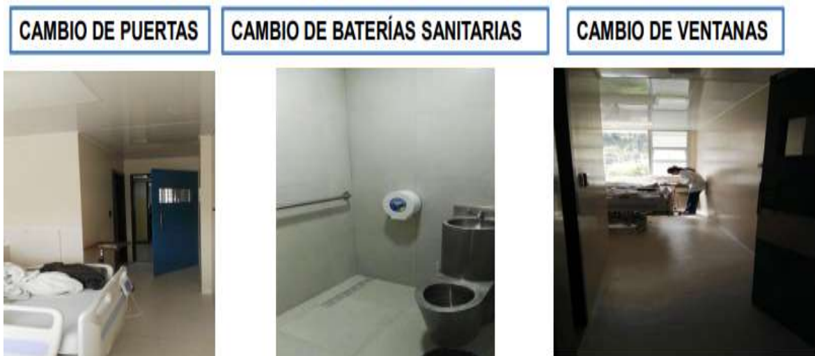
Figura 2. Adecuación de áreas de salud mental.
