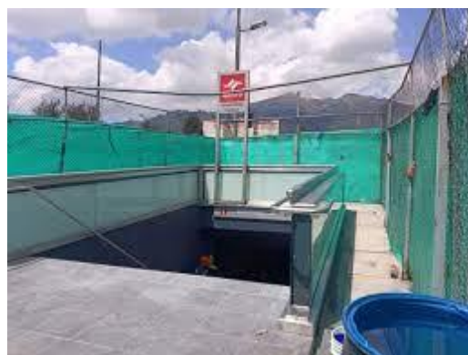
Ilustración 51: Bocas de Metro
