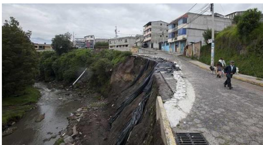
Figura 14. Quebrada Rellenada para ejecutar la sección vial
