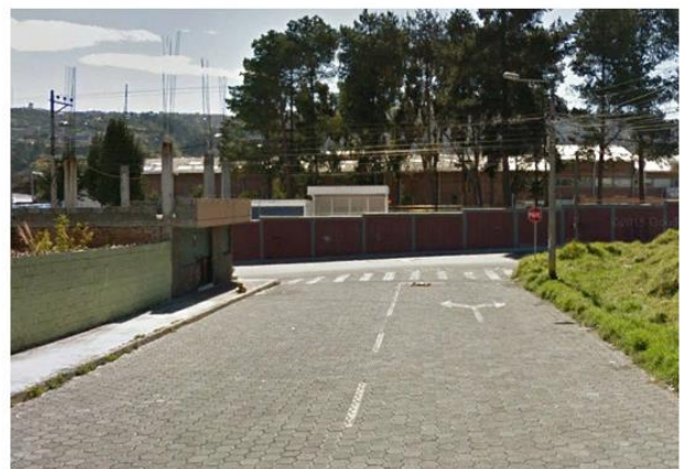
Foto 6 El Estado de la acera es malo, un tramo de la acera no está construido.
