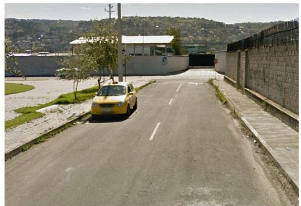
Foto 12 El Estado de la acera es regular, se pueden observar tramos sin acera y no existe accesibilidad universal.
