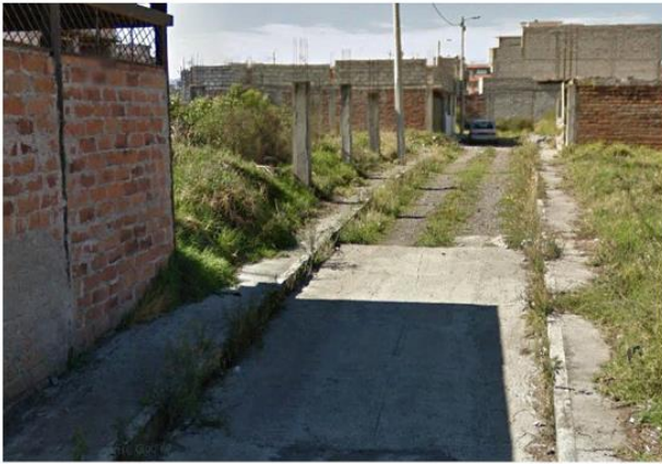
Foto 9 El Estado de la acera es malo, no existe acera.
