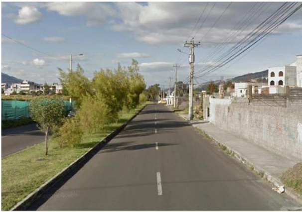
Foto 1 El Estado de la acera es regular, se pueden observar tramos sin acera y no existe accesibilidad universal.
