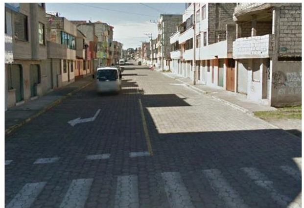
Foto 4 El Estado de la acera es regular, no hay continuidad en el tramo y existen barreras como postes.
