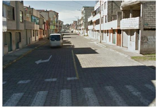
Foto 8 El Estado de la acera es regular, no hay continuidad en el tramo y existen barreras como postes.
