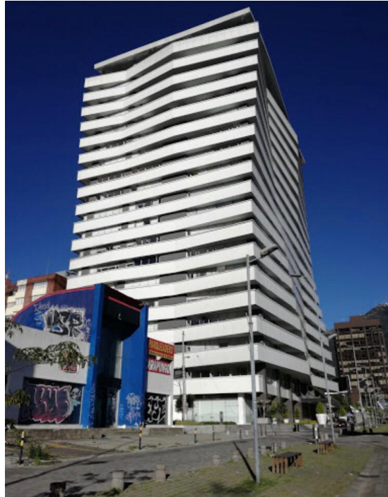
Figura 64. Fotografía de peatón del Edificio Metropolitan Tomado de (Google Images, 2019).
