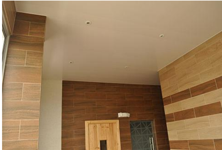
Figura 62. Cielo raso en áreas húmedas del proyecto.
