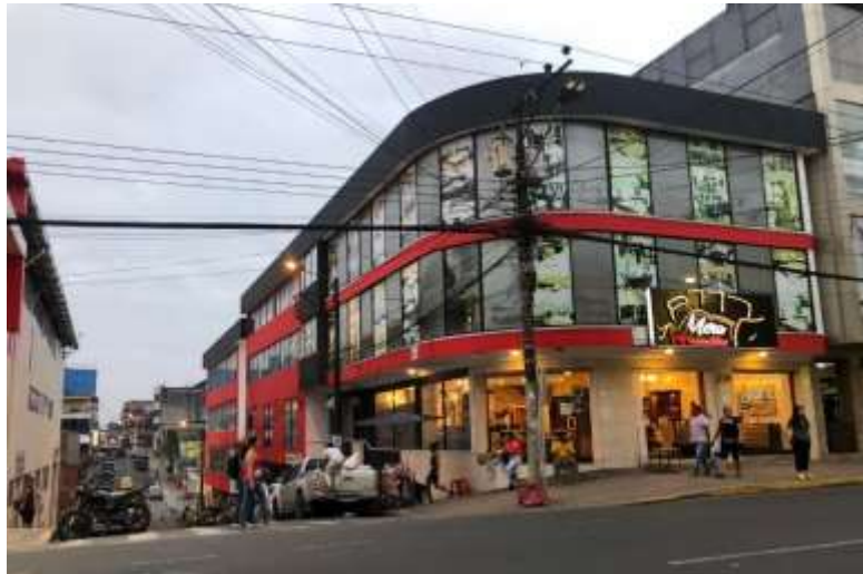
Figura 51. Construcción fachada principal
