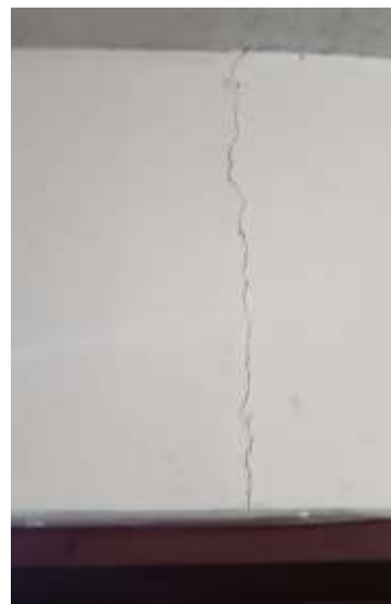
Figura 53. Vista interior Paredes
