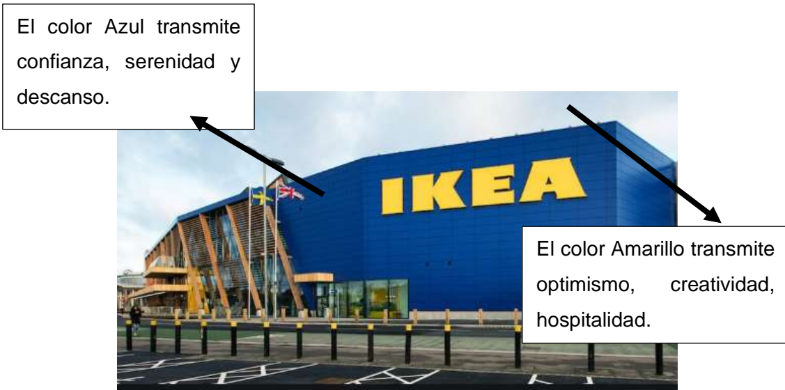
Figura 22. Fachadas de Tiendas Independientes.
