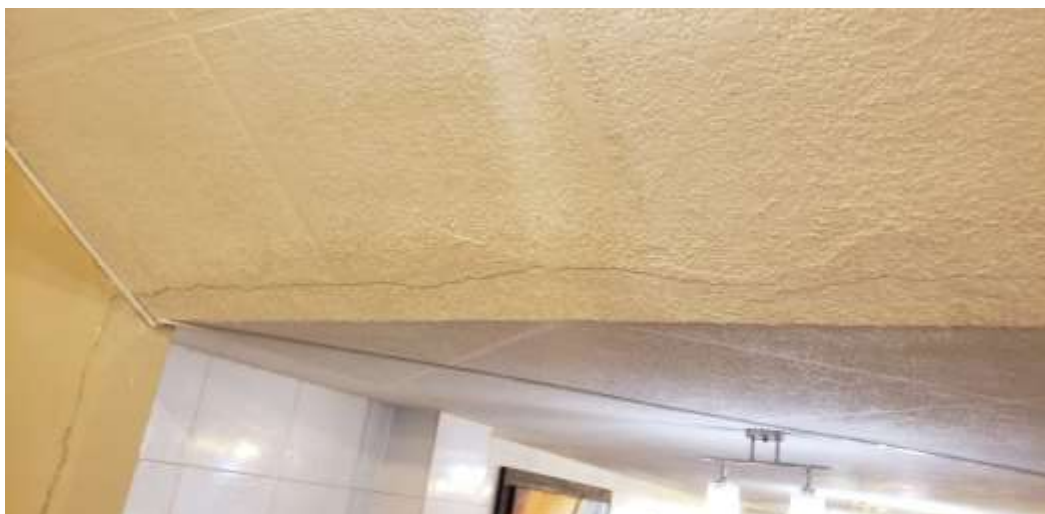
Figura 55. Vista interior techo.
