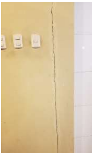
Figura 52. Vista interior Paredes
