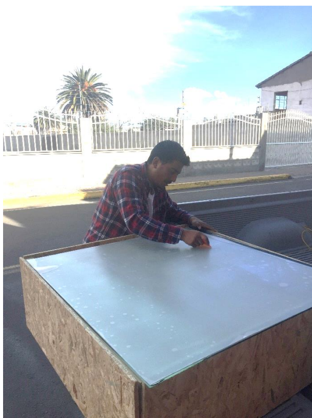
Pegado de lámina inteligente PDLC sobre la cara de vidrio 6mm
