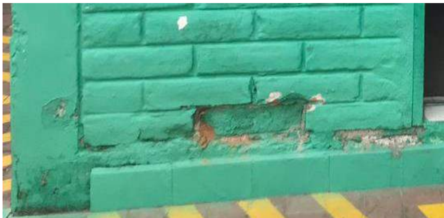
Figura 75 Deterioro Mampostería
