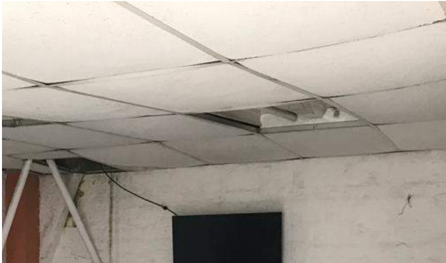
Figura 78 Cielo Raso - Comedor
