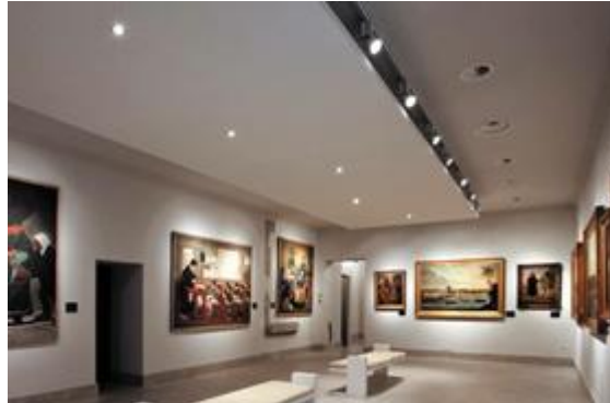
Figura 19. Iluminación general y puntual en sala de exhibición Tomado de: (EVE Museografía, 2015)
