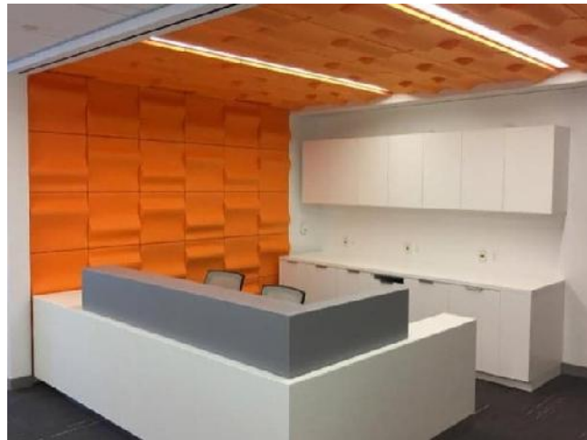
Figura 18 Paneles acústicos en pared y techo.
