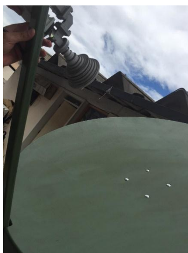
Figura 107. Instalación de LNB banda Ku.
