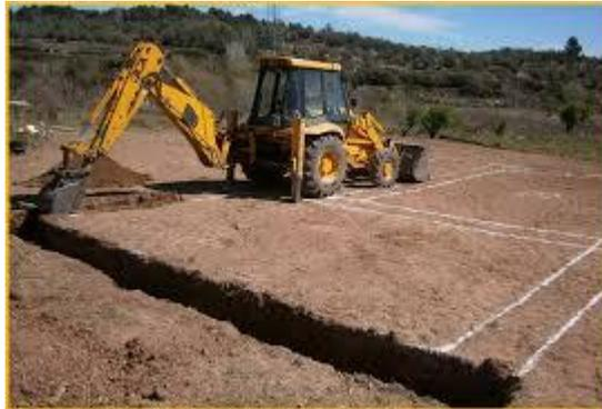
Figura 21 Excavación de Cimientos
