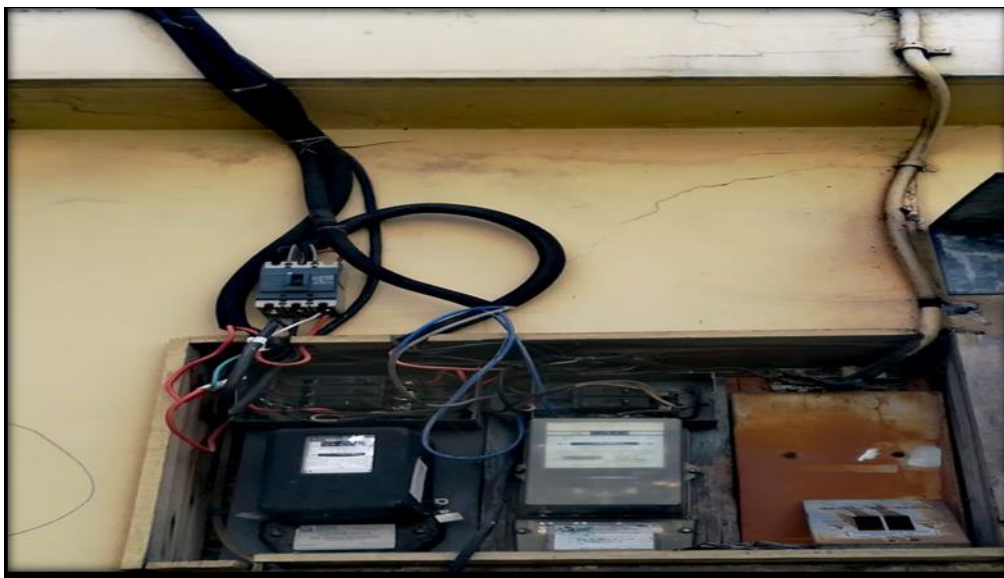
Figura 5. Instalación de Medidores
