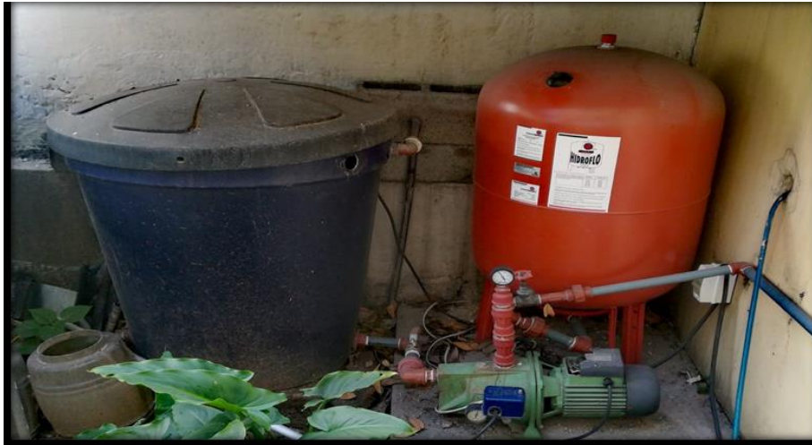
Figura 6. Instalación de Agua Potable
