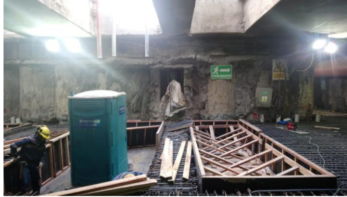
Figura 75 Demolición colector antiguo Fecha: 06 de agosto del 2018
