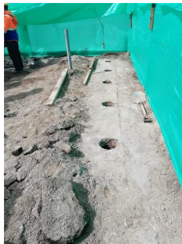
Figura 40. Proceso de perforación
