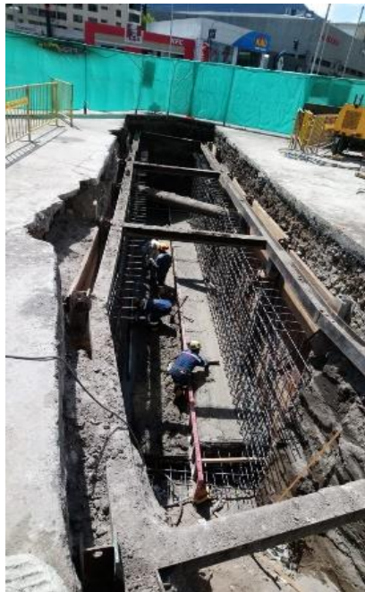
Figura 73 Proceso hormigonado solera Fecha: 06 de agosto del 2018
