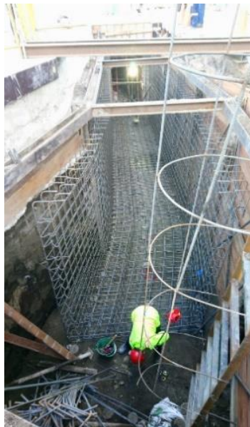
Figura 72. Proceso de armado de acero Fecha: 06 de julio del 2018
