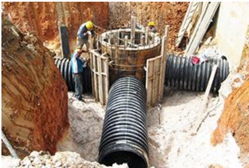
Figura 9. Alcantarilla Tomado de: (TDM, 2016)
