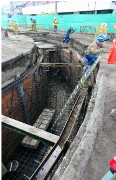
Figura 74 Armado de acero Fecha: 06 de agosto del 2018
