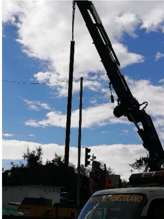
Figura 43. Proceso de colocación de micropilotes
