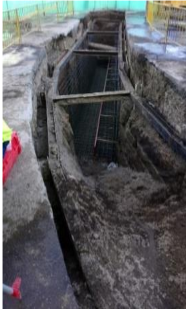
Figura 71. Proceso de remoción de tierra Fecha: 06 de julio del 2018
