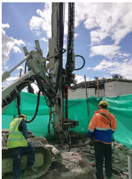
Figura 21. Perforadora para micropilotes
