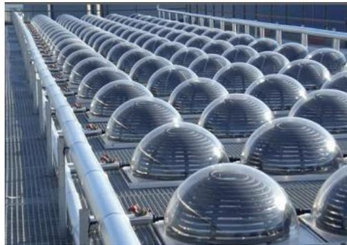
**Figura 11.** Panel Solar tipo domo. Tomado de: <http://www.sitiosolar.com/bubblesun-el-colector-solar-semiesferico/>
