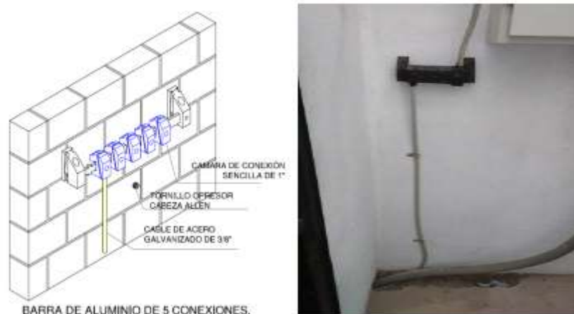
Figura 105 Instalación de Barra btcc.
