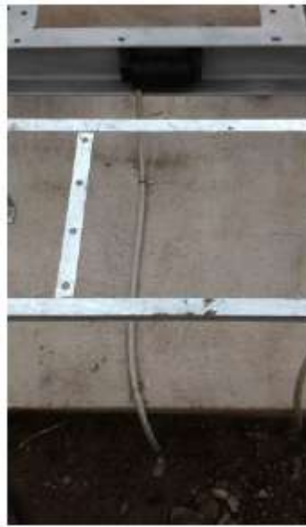
Figura 106 Instalación de Barra bts.
