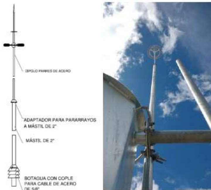
Figura 111. Instalación de pararrayos
