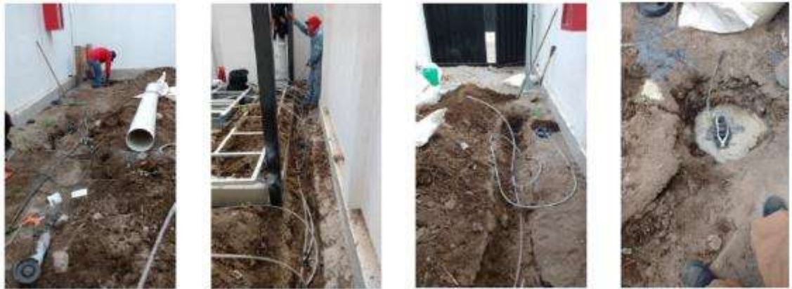
Figura 112 Instalación de mayas
