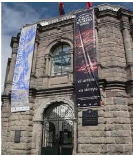
FOTOGRAFÍA 3.1 Vista frontal del exterior del CCM
