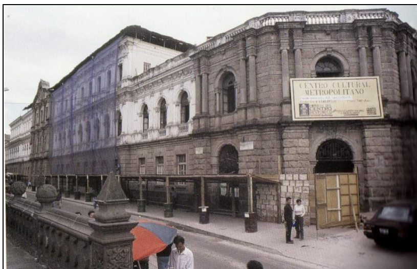
FOTOGRAFÍA 3.8 Proceso de rehabilitación del nuevo Centro Cultural Metropolitano
