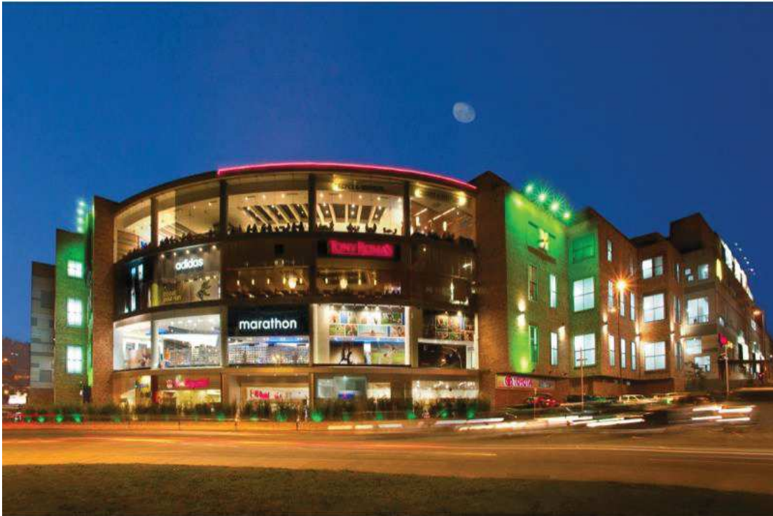
Fachada del centro comercial Condado Shopping
