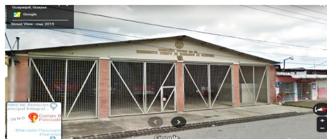
FIGURA 12. CUARTEL DE BOMBEROS PASCUALES.
