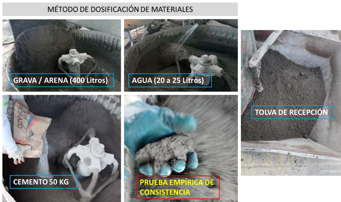
Figura 9. Método de dosificación actual
