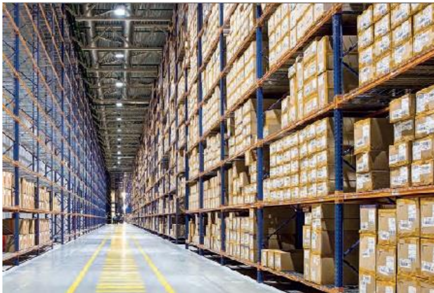
Figura 47: Ejemplo de bodega de almacenamiento
