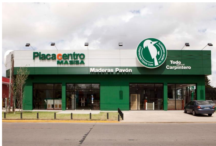
Figura 20. Fachada de Placacento. Tomado de (Página web oficial Placacento Masisa).
