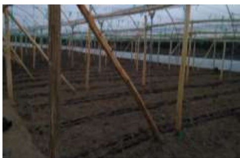
Colocación cintas de goteo
